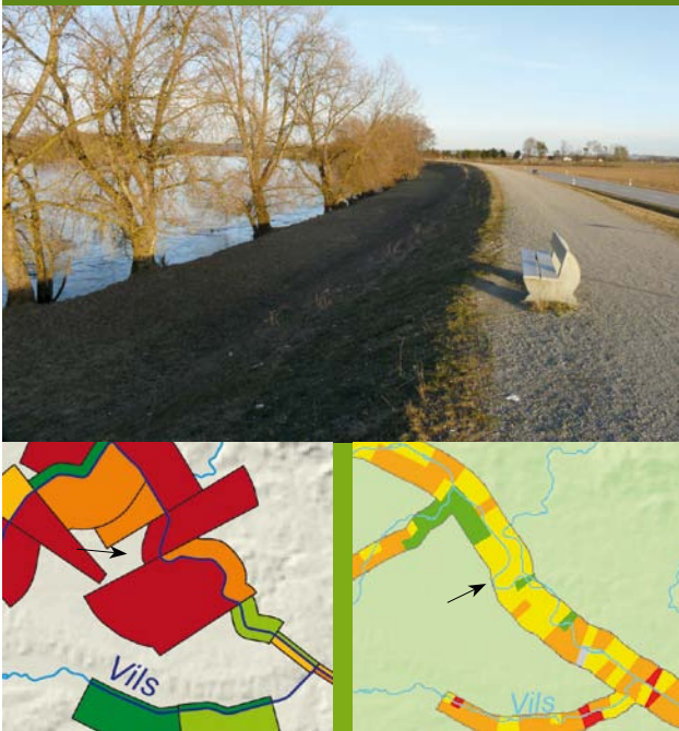
Abbildung 20: Hochwasserschutzdeich mit angrenzender intensiver Nutzung in der Altaue (unten links: Auenverlust, unten rechts: Auenzustand)
