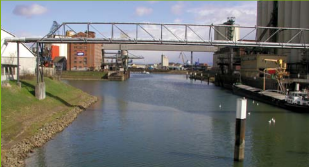
Abbildung 13: Massiv ausgebauter Hafbereich
