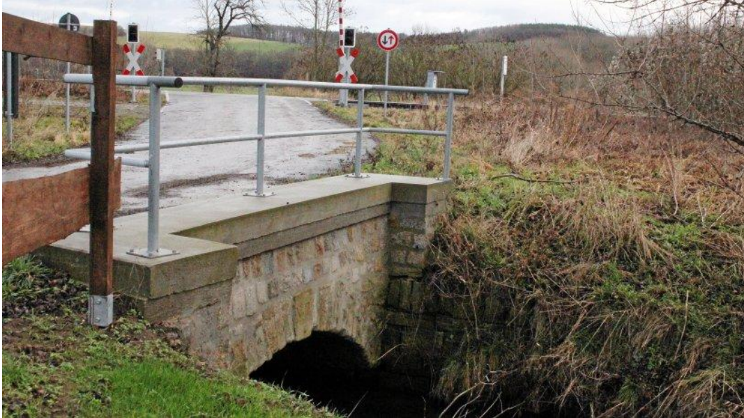
Das Archivbild zeigt die Floßgrabenbrücke Nummer drei vor dem Abriss des Denkmals Anfang 2016. Foto: Angelika Munteanu
